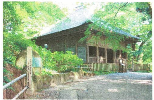
金色堂を覆っていた古い覆い堂
